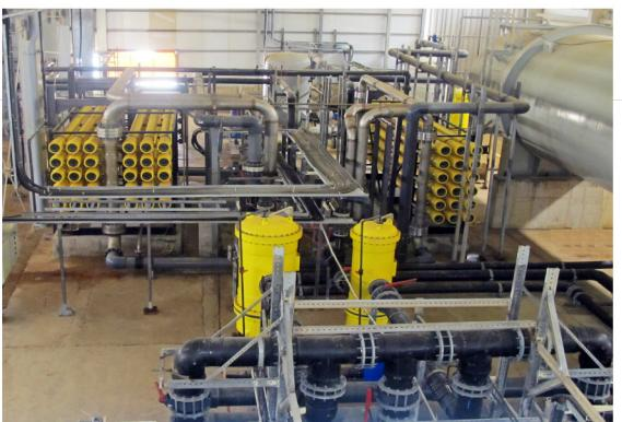
استفاده از سیستم یک بارگذرجهت دستیابی به کیفیت مطلوب آب آشامیدنی بر اساس استاندارد اروپا مناسب می باشد. بکارگیری فناوریهای به روز و بهینه سازی شرایط تولید آب با کیفیت مطلوب با حداقل هزینه، از مزایای چشمگیر بکارگیری پکیج شیرین سازی اسمز معکوس ساخته شده توسط شرکت مهندسی فران می باشد.
